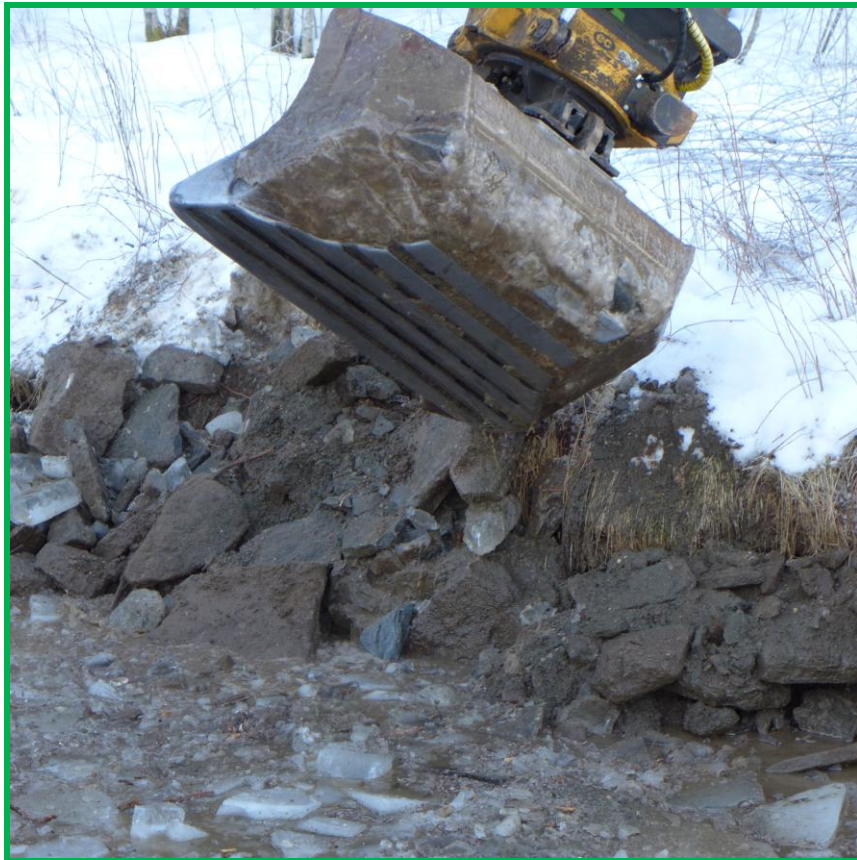
Utlegging av stein med vribar skuffe.
