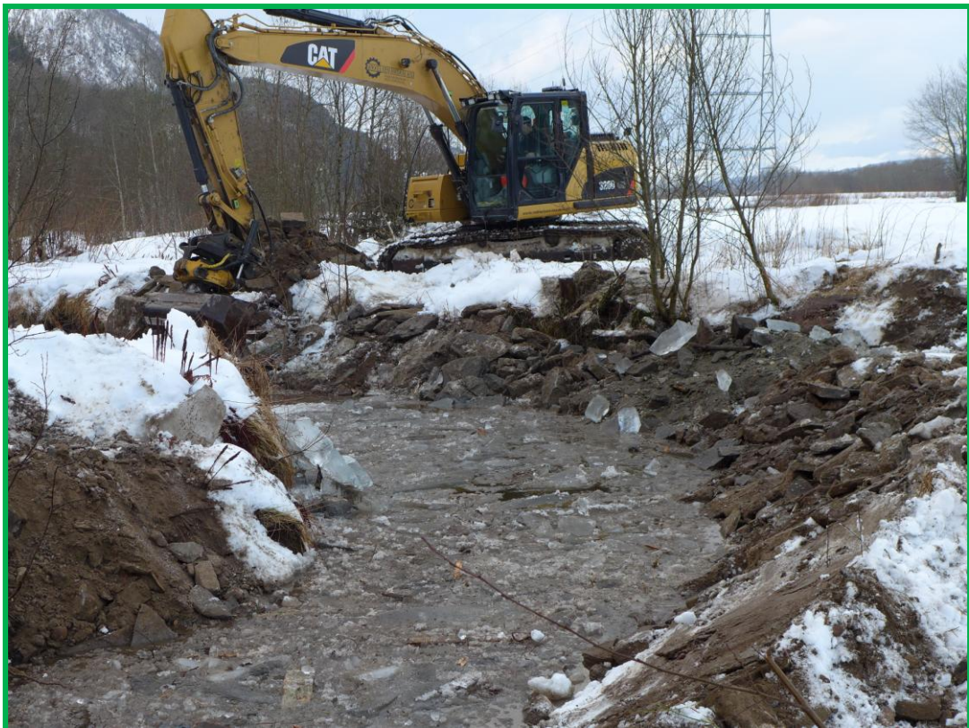
Utlegging av stor stein med gravemaskin.
